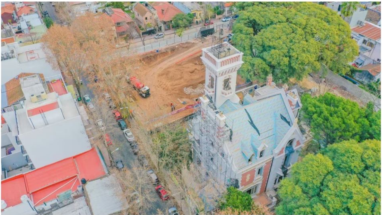
En San Fernando, además del mercado de usados, hay varias obras en construcción en el casco urbano de la ciudad
