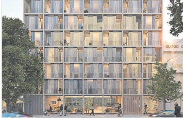
Proyectos de pozo. Una opción ideal para quienes están interesados en invertir (Proyecto Uno Balvanera).
